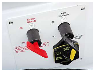
Fachmännisch: Die Batterieanlage ist unterhalb der Cockpitbank installiert
